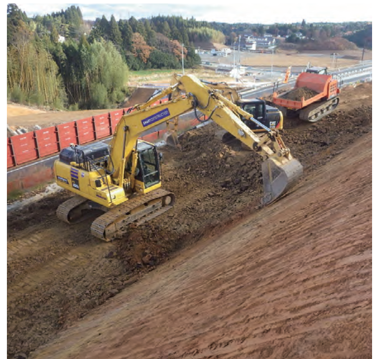
▲ICT建機による施工の効率化・省力化
